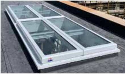
Einzelgerät auf Sockel auf einem Industriedach
