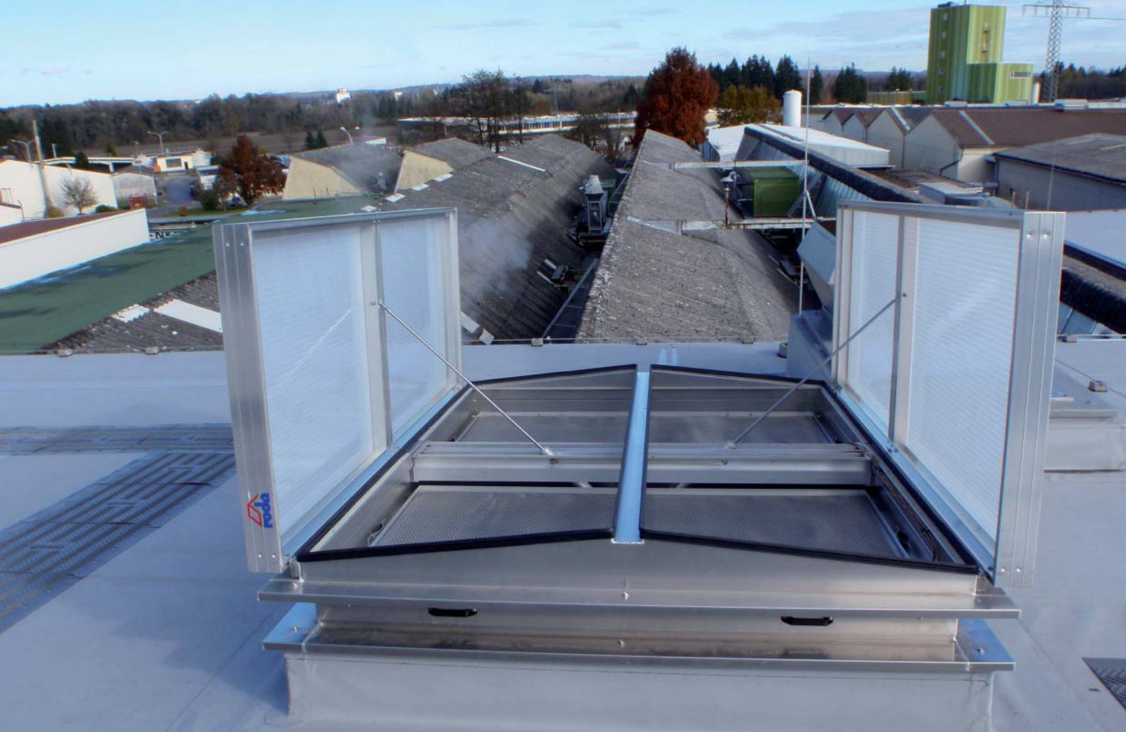
Auch zur täglichen Lüftung öffnen die Hauben auf einen Winkel von 90°.
