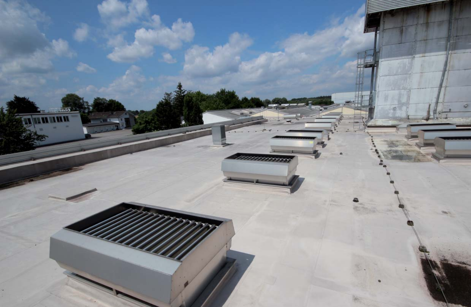
Mehrwecklüfter vom Typ MULTIJET, die auch bei Regen zur Lüftung eingesetzt werden können.
