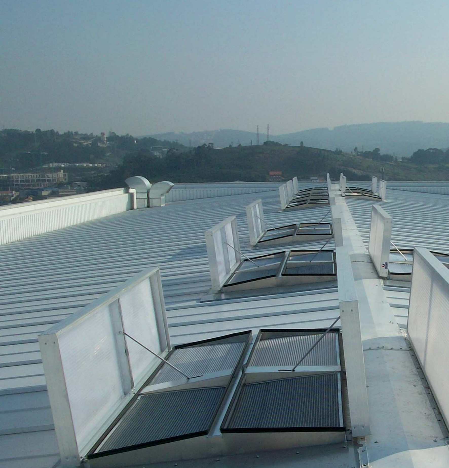
RWA- und Lüftungssysteme vom Typ PHÖNIX, die mit Insektenschutz ausgestattet sind
