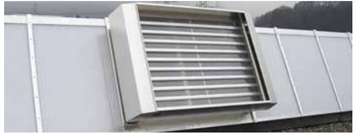
MULTIJET mit PC-Lamellen als Lüftungsgerät in ein DELTA-LIGHT integriert
