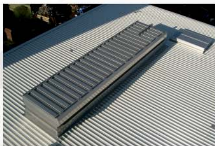
AIRSTAR mit geschlossenem Schieber
