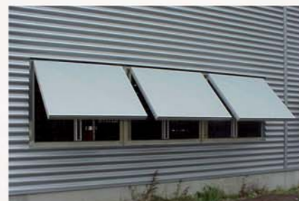
PHÖNIX als Zuluftgerät in der Wand
