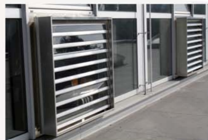
SMOKEJET vertikal eingebaut
