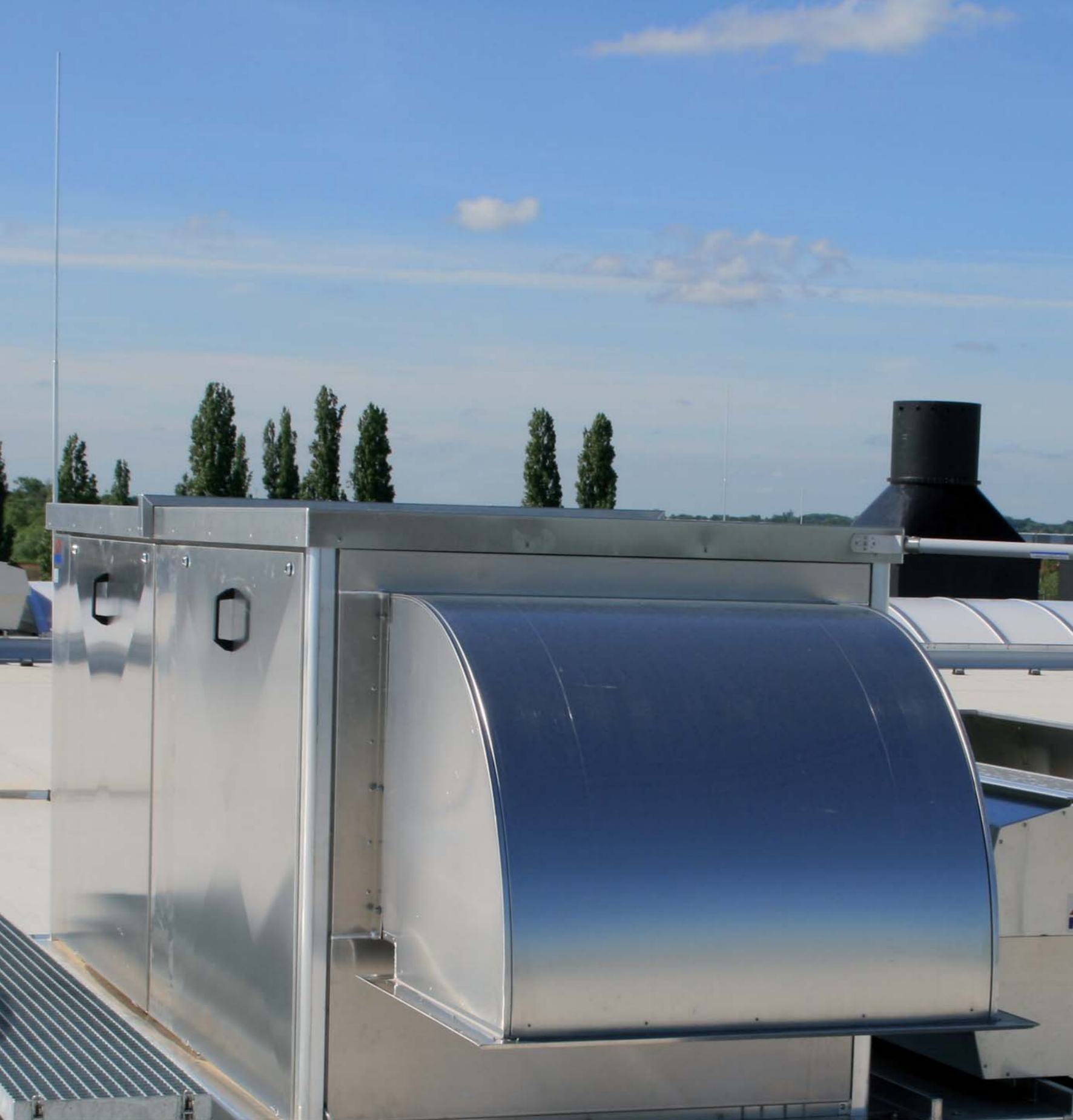
Großes Bild: Eine in ein EUROLIGHT integrierte, mechanische Lüftungseinheit Typ ISOVENT
