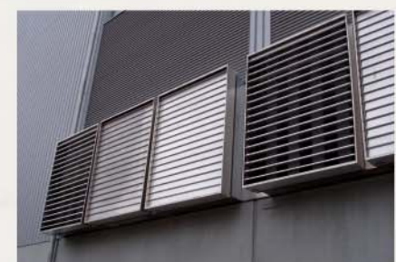
SMOKEJETs als seitliche Zuluftöffnung
